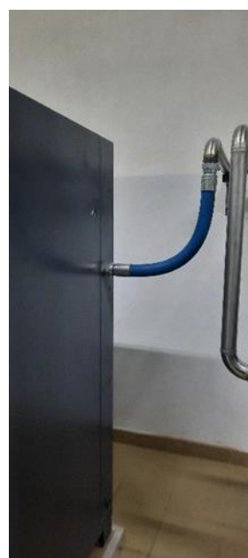
Примеры неправильного монтажа пнев-
