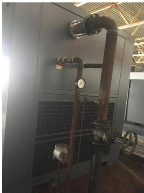
Примеры неправильного монтажа пнев-
